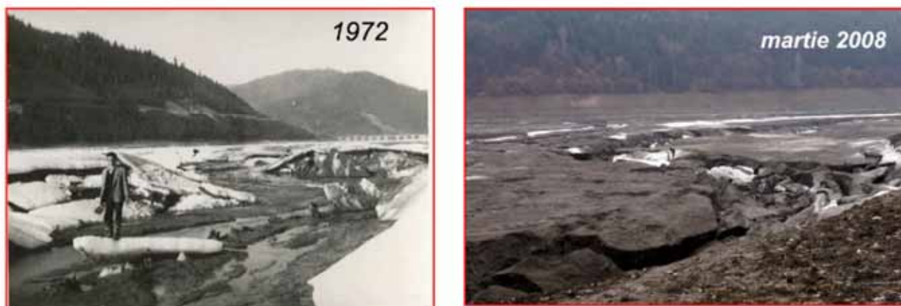
Fig. 9. Obturarea cu năboi a albiei râului Bistrița a determinat schimbarea cursului râului (zona Călugăreni în cuveta emersă a lacului Izvoru Muntelui): 1972 (foto I Miron); 2008 (foto N. Rădoane).
